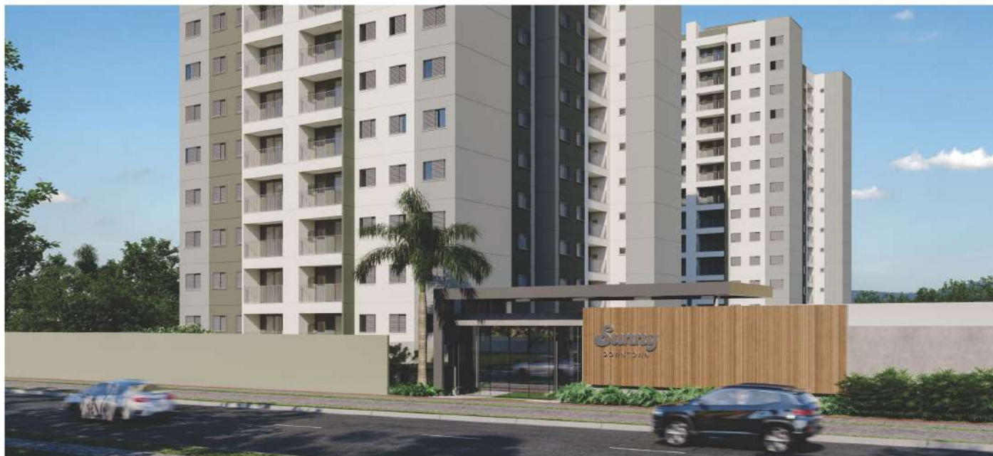
Lançamento da Yticon próximo ao Shopping Boulevard, em Londrina.
