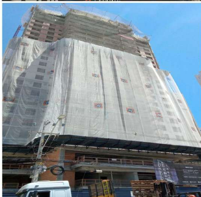
Obras em execução do Grupo A.Yoshii.
