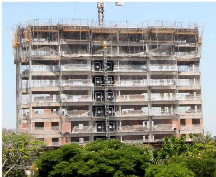
Construtora executa mais de 35 obras no setor de Incorporação em 2022.
